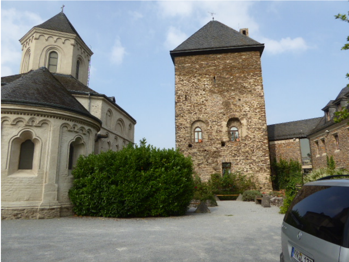
Abb. 14 Der alte Burgturm neben der Kapelle mit Zugang zur Gastwirtschaft
