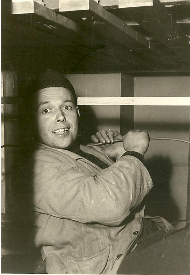
Werner als Helfer beim Orgelbau in Nordfrankreich 1995
